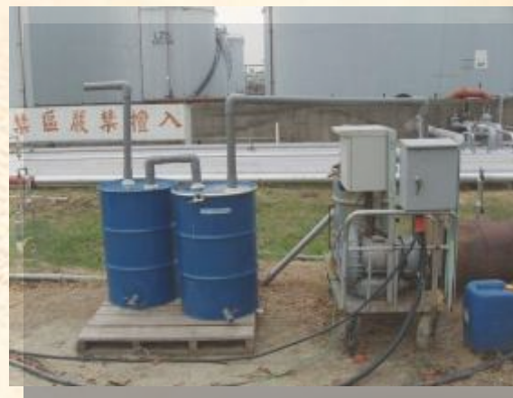
設置污染改善設備，去除地下環境污染物
