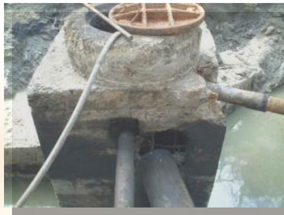
修補破損的方井
