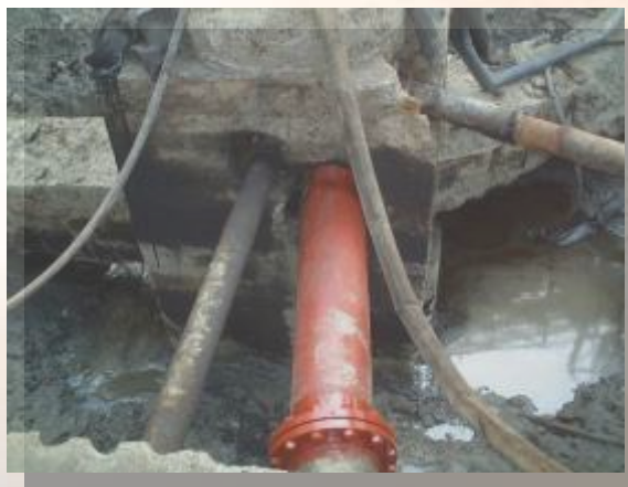
開挖查漏，找出污染源
